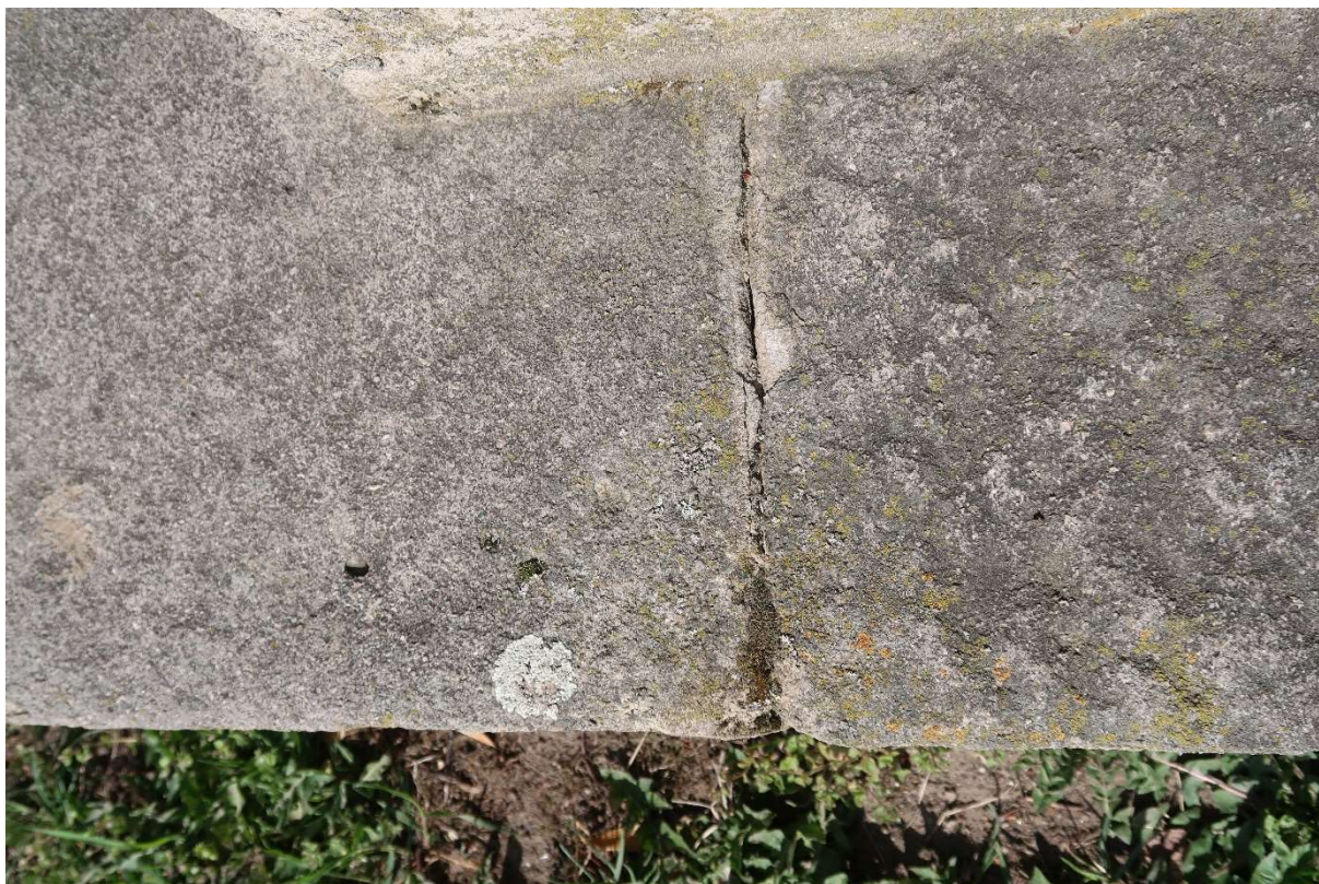
Stav před restaurováním, uvolněné spáry
