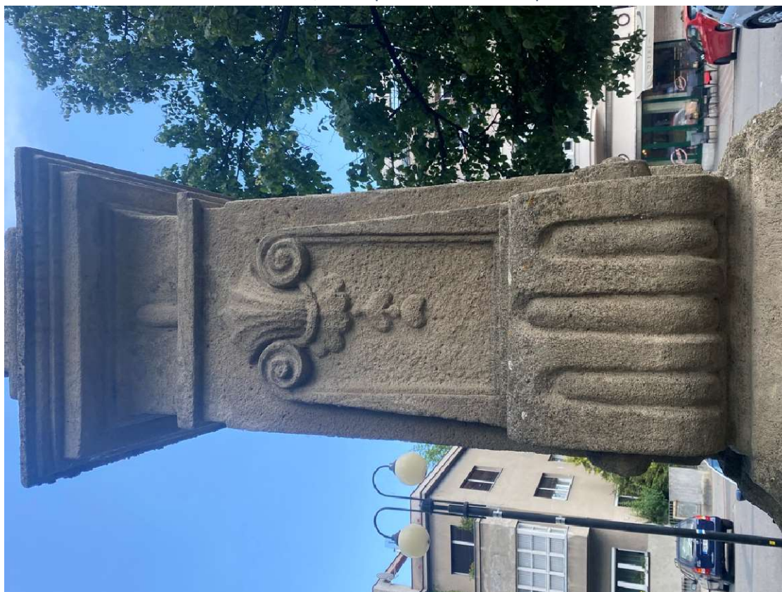
Detail voluta, boční pohled: biocidní napadení
