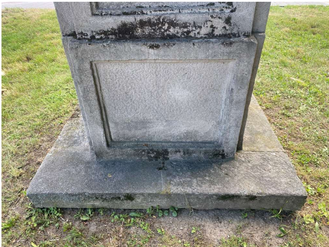
Sokl: prasklina, biocidní napadení, tvorba krust
