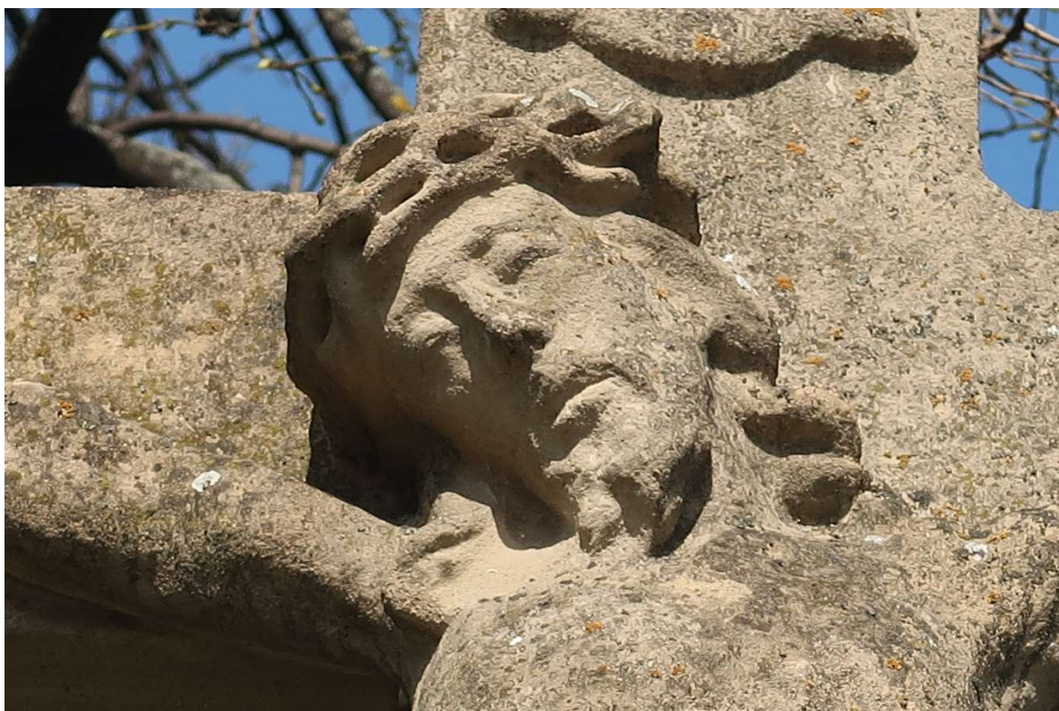
Stav před restaurováním, detail napadení – kolonie mechů a lišejníků
